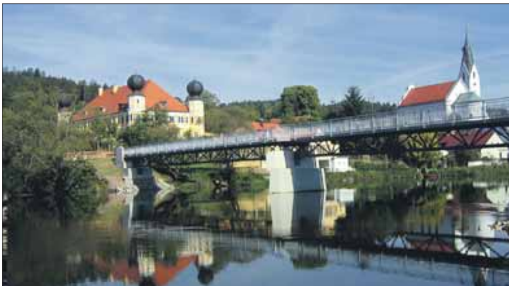
„Brücken bauen“ meint viel mehr als nur den technischen Bau - es ist eine Kulturleistung, die die Menschen verbindet und damit nicht nur Verkehrsinfrastruktur sicherstellt, sondern Lebensqualität schafft. Im „Golddorf“ Rampsau freut man sich über die neue Regenbrücke. Der Regenstauffer Ortsteil feierte kürzlich die Einweihung des Bauwerkes, das sich harmonisch in die großartige Landschaft des Bayerischen Waldes einfügt (vgl. Seite 9). □
