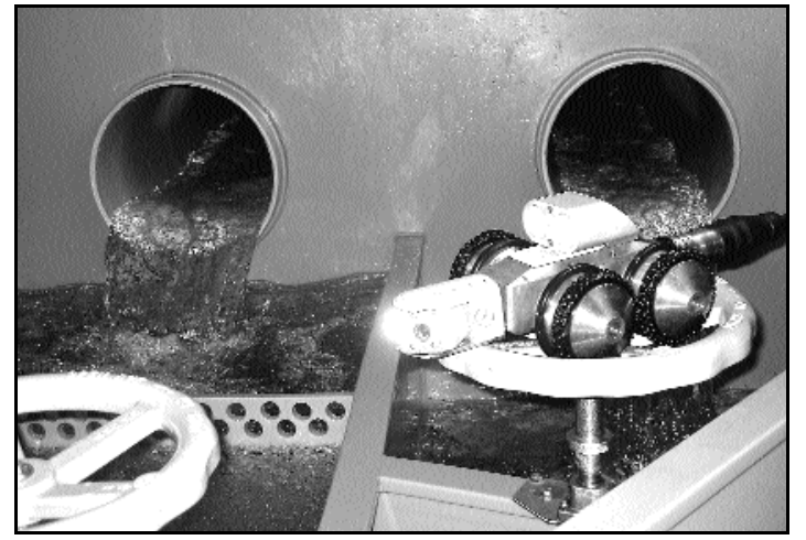
Modernste Ortungs- und Kameratechnik ermöglicht eine regelmäßige Zustandskontrolle von Quellsassungen. □
