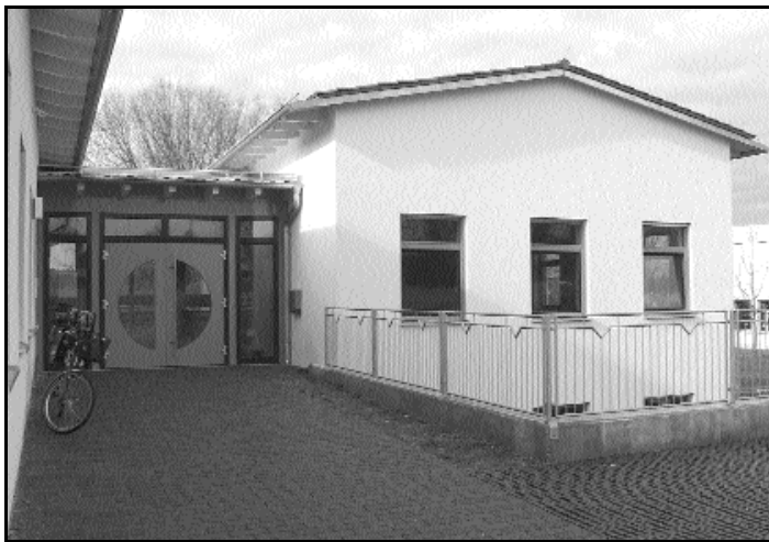
Aus dem Öko-Baustoff Poroton T9 von Schlagmann ist jetzt im bayerischen Siegenburg eine Mehrzweckhalle für Kindergartenkinder entstanden. Bild: Schlagmann Baustoffwerke
