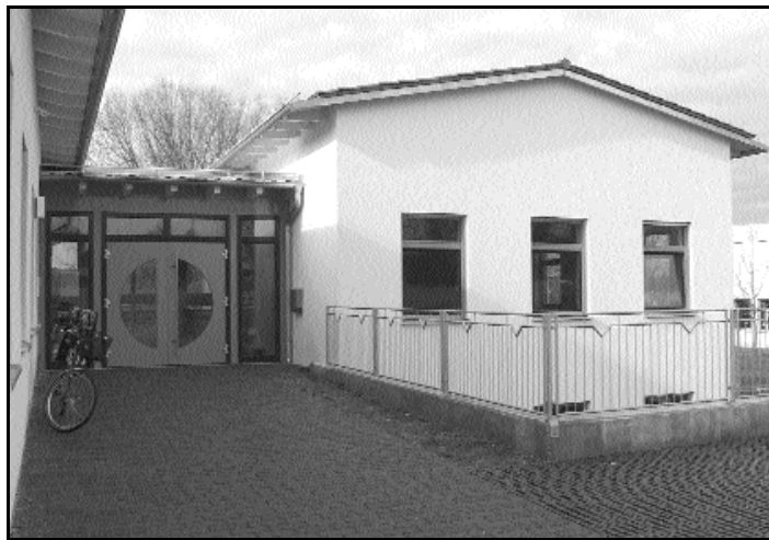
Aus dem Öko-Baustoff Poroton T9 von Schlagmann ist jetzt im bayerischen Siegenburg eine Mehrzweckhalle für Kindergartenkinder entstanden. Bild: Schlagmann Baustoffwerke
