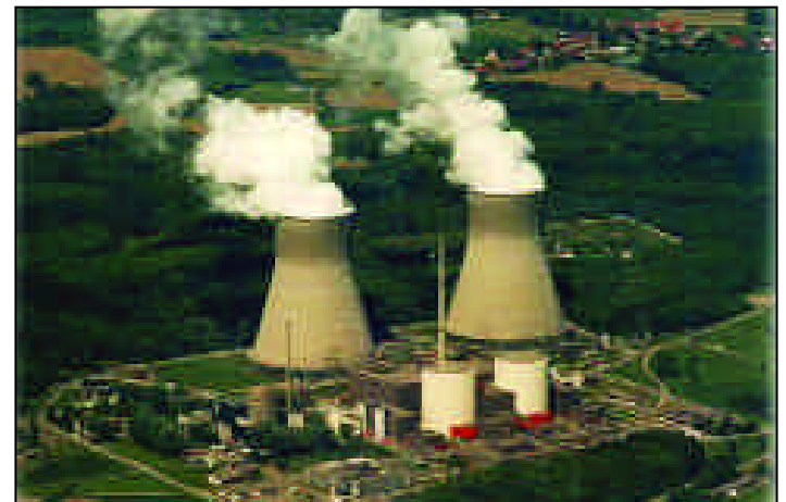
Die zwei 160 Meter hohen Kühltürme prägen das Bild der Gundremminger Kernkraftwerke.
