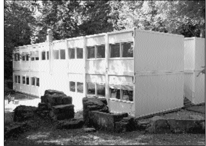
Innerhalb von nur sechs Wochen wurden Ersatzräume bereitgestellt und somit das größte Containerdorf Baden-Württembergs errichtet.
