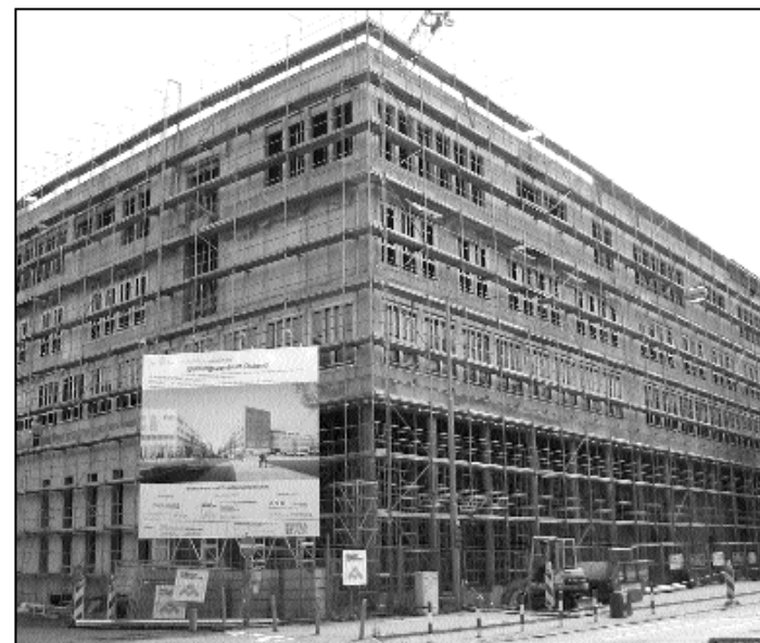
Bildungszentrum Ostend im Rohbau.
