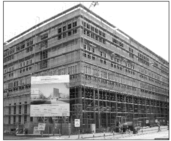
Bildungszentrum Ostend im Rohbau.
