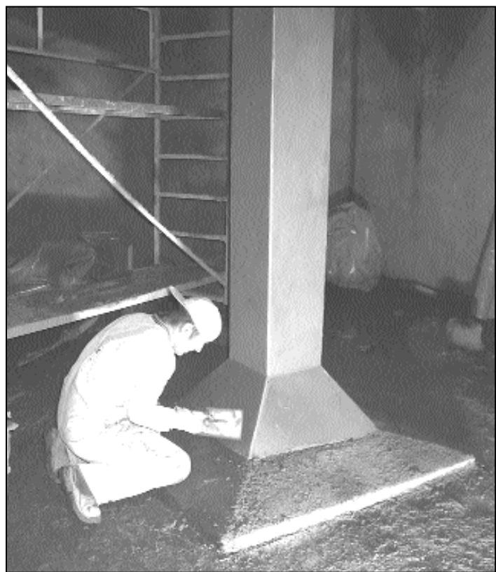
Beschichtung der Stützen in der Wasserkammer. Foto: KBK AG
