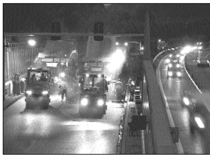
Innerhalb von 44 Stunden, rund um die Uhr asphaltierten die Riebel Schwarzdeckenbauer ein Teilstück der A 96, Lindau-München, zwischen Anschluss Windach und Echinger Tunnel.
