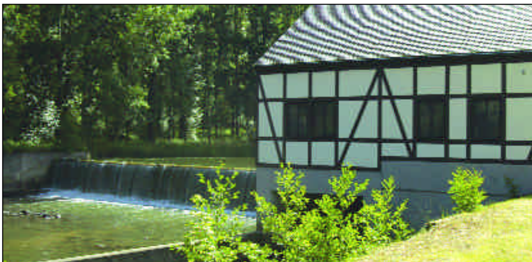
Fast 90.000 Euro investierte man in die Sanierung des Flusskraftwerks Hammer. ☞
