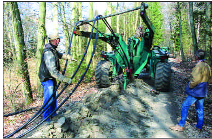
Die Verkabelung der Mittelspannungsfreileitungen ist heuer ein besonderer Schwerpunkt des Bauprogramms von E.ON Bayern. Daneben wird durch die Erneuerung älterer Ortsnetz-Freileitungen sowie Modernisierung und Erweiterung der netztechnischen Infrastruktur auf der 20 kV-Ebene das Leitungsnetz auf den neuesten Stand der Technik gebracht. Unser Bild entstand an der Strecke zwischen Leinach und Billingshausen.
