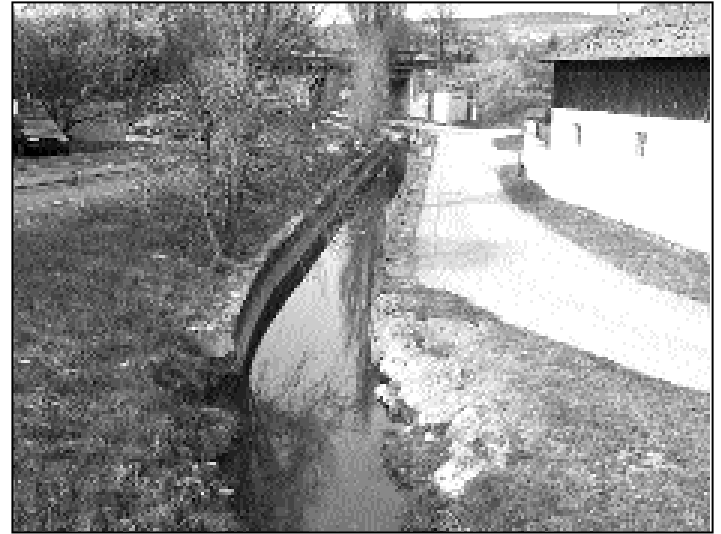
Krumbach Gärmersdorf: Zum Teil wurde in der Vergangenheit sehr nahe an den Fluss gebaut und der Fluss selbst begradigt oder zum Kanal umgestaltet.
