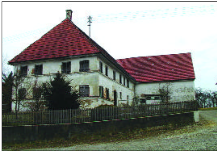
Leerstehende Gebäude an ortsbildprägender Stelle erfordern dringend eine Problemlösung. Text und Bild: Joas
