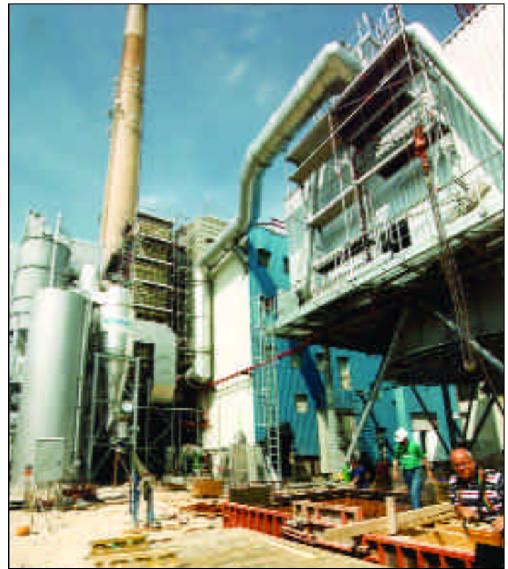
Baustelle im Juni 2003.
