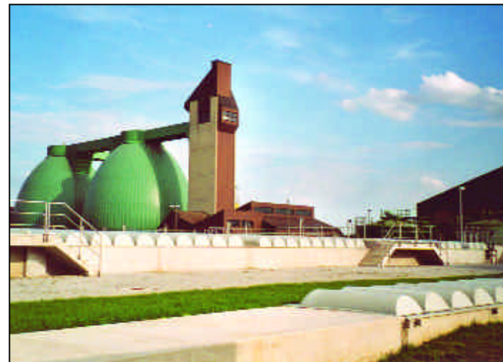
Um Geruchsbelästigungen der Umgebung zu vermeiden, ist die Regensburger Großkläranlage vollständig nach oben und seitwärts abgedeckt. Im Hintergrund befinden sich die 30 m hohen Faultürme. Bild: W. Zeitler
