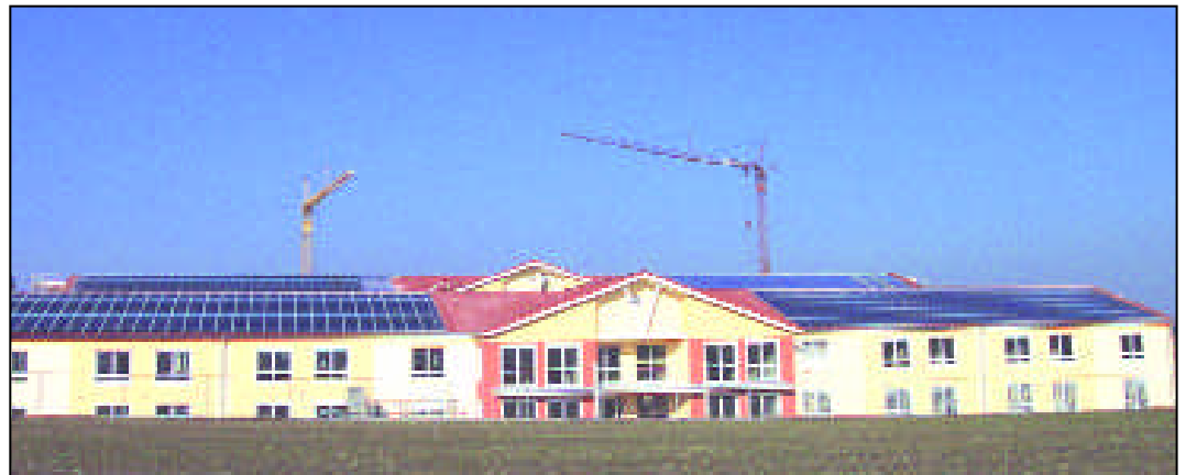
Eine innovative, architektonisch elegante und wirtschaftliche Montagetechnik der Solartechnik setzt, wurde bei den Barmherzigen Brüdern in Gremsdorf installiert.
